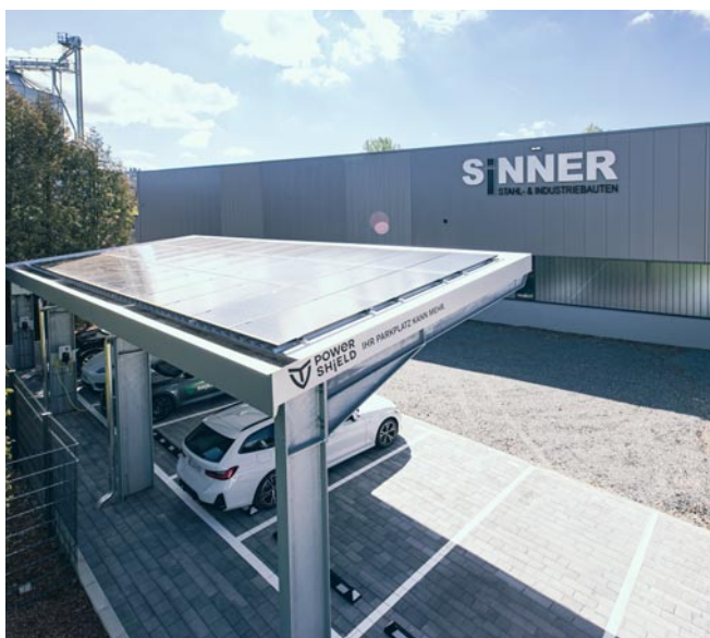
Die Ladeinfrastruktur der Carports ist im Handumdrehen installiert. (Fotos: PowerShield GmbH)
