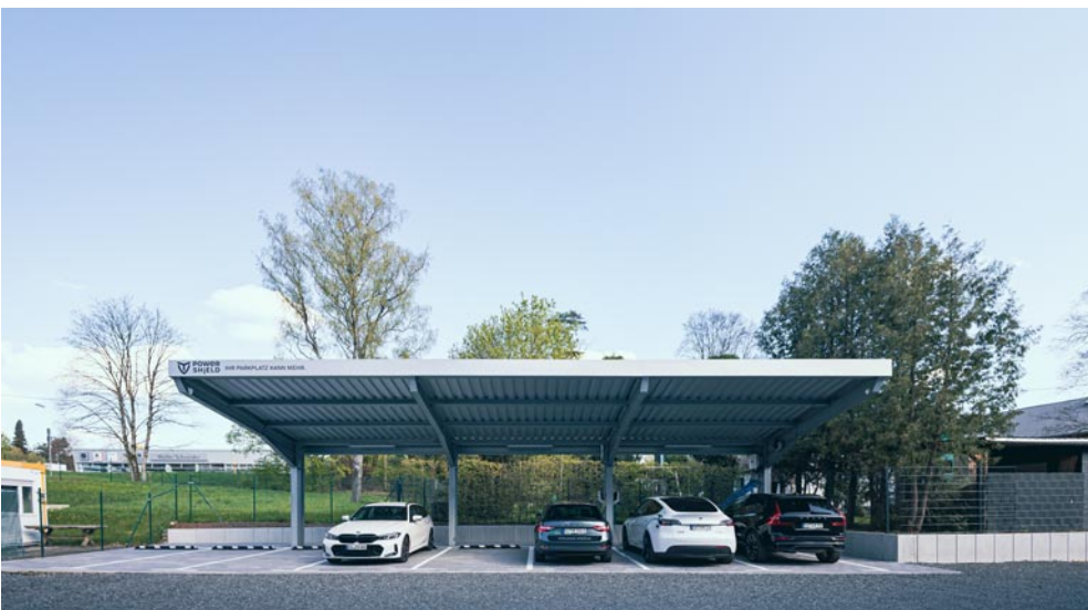
Die Vorführanlage der Firma PowerShield steht am Sitz des Familienunternehmens der SINNER Stahl- und Industriebauten GmbH in Kreuztal-Ferndorf.
