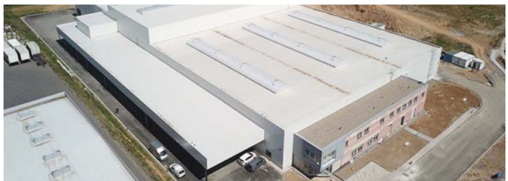
Bau des neuen Produktionswerkes Askay II. (Foto: GEDIA Gebrüder Dingerkus GmbH, 2019)
